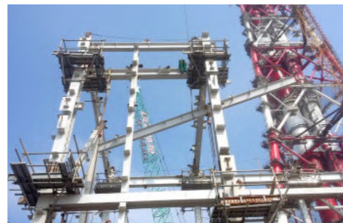
Lắp đặt limestone milling house
