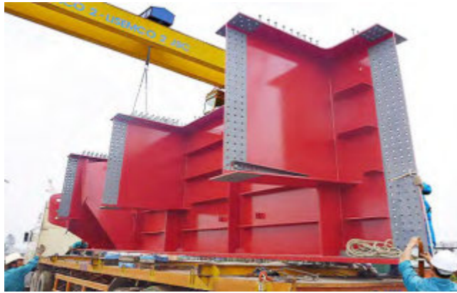
Gia công chế tạo kết cấu cầu
