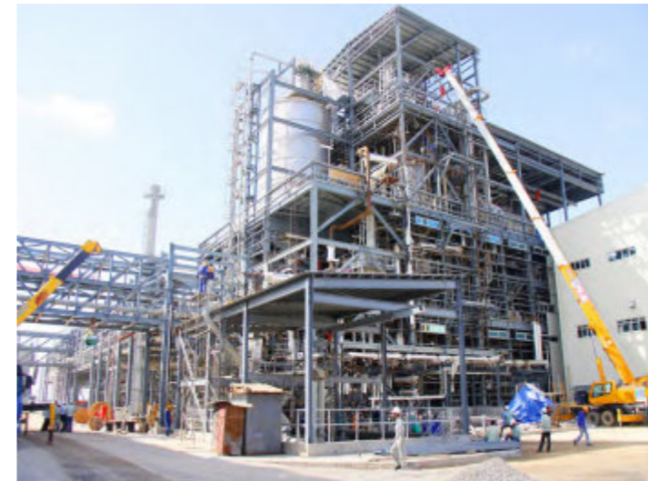
Lắp đặt kết cấu thép, thiết bị và ống nhà máy Xơ Sợi Polyester Đình Vũ
