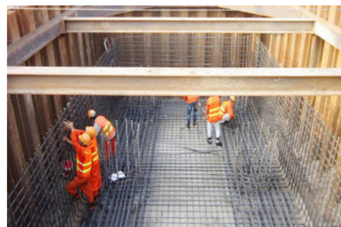
Thi công phần móng
