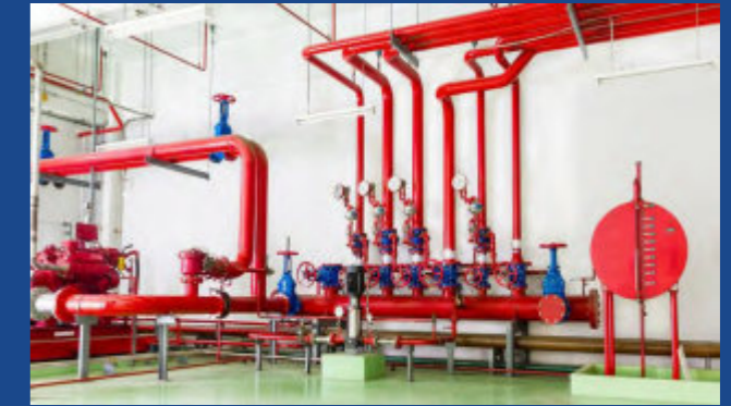
Hệ thống điện cho hệ thống cứu hỏa
