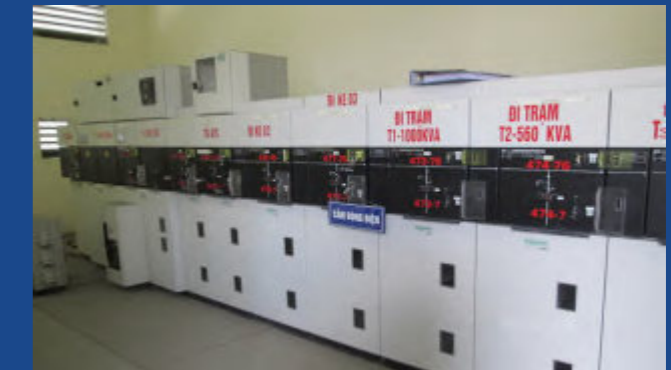
Lắp hệ thống điện cho nhà điều hành
