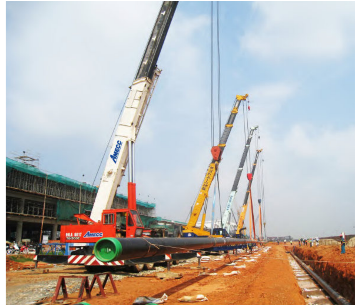
Lắp đặt đường ống ngầm
