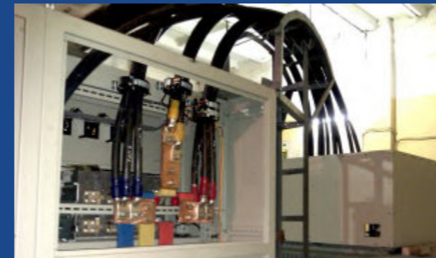
Lắp hệ thống điện cho công trình
