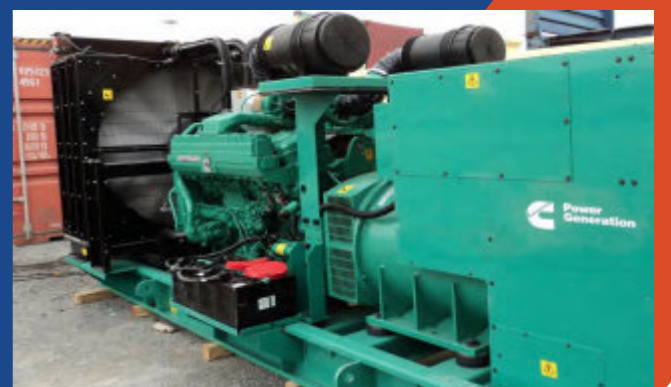
Sửa điện cho máy phát điện công nghiệp
