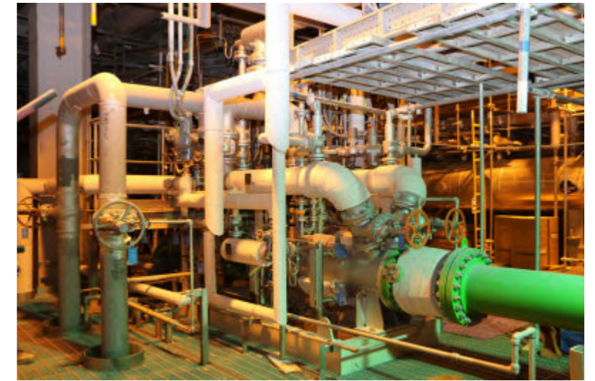
Lắp đặt đường ống công nghệ nhà máy nhiệt điện
