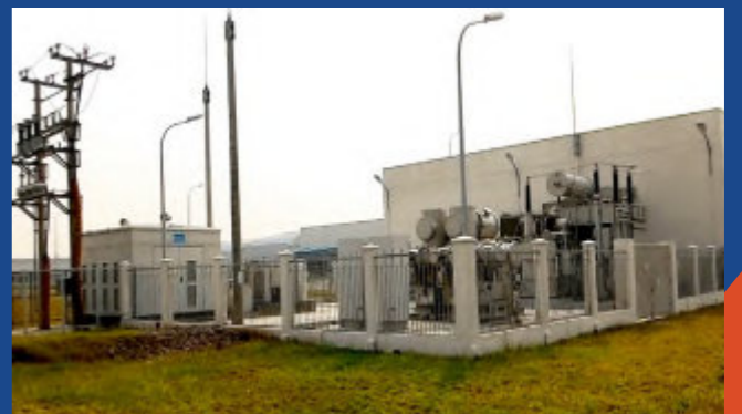
Lắp điện cho trạm biến áp
