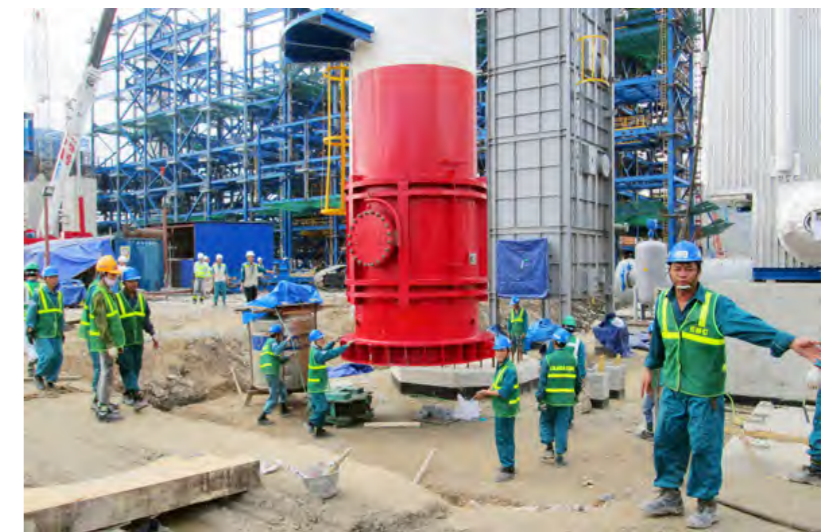
Lắp dựng cột ống khói cho công trình nhiệt điện
