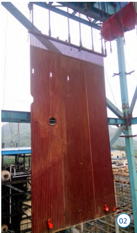
Lắp đặt bao hơi nhà máy mía đường Tuyên Quang
