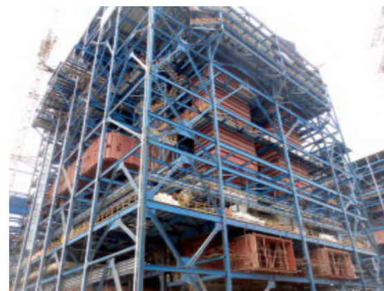
Lắp đặt ống gió nhà máy nhiệt điện Vũng Áng 1
