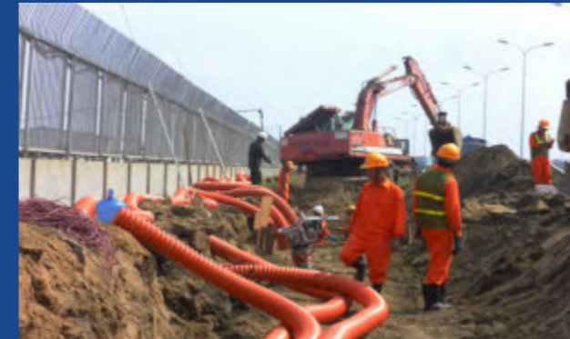
Lắp điện trong công trình dự án
