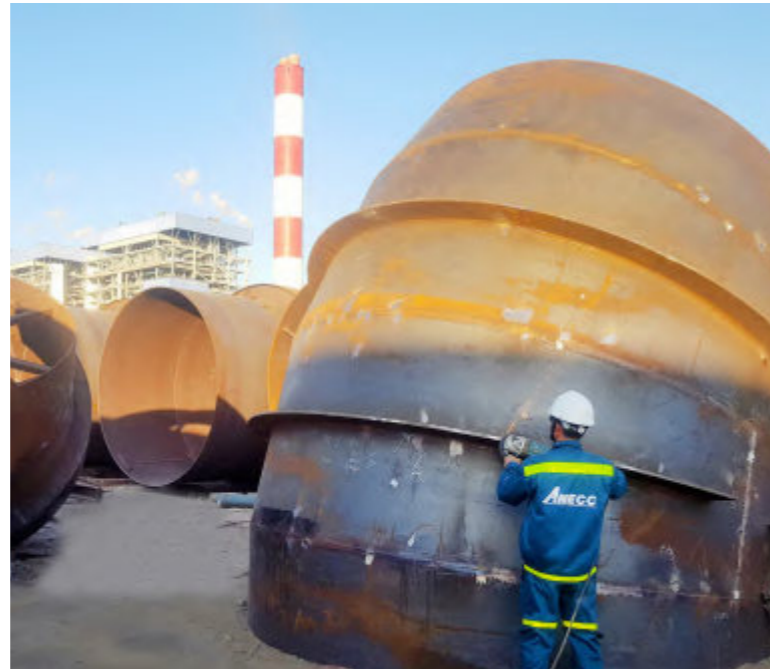
Gia công đường ống làm mát tuần hoàn
