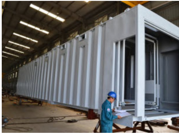
Gia Công chế tạo cầu hành khách sân bay Changi – Singapore
