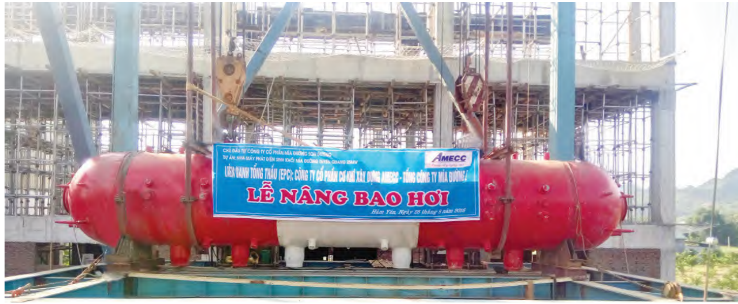
Lắp đặt bao hơi nhà máy mía đường Tuyên Quang
