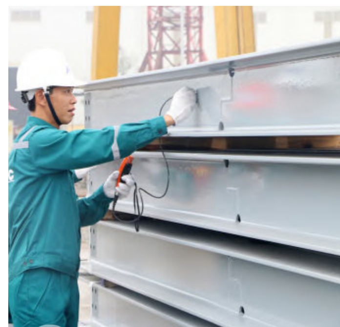
Gia công chế tạo kết cấu thép cho dự án nhiệt điện Barh - Ấn Độ
