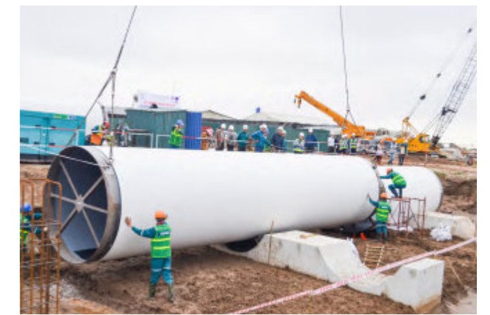
Lắp đặt hệ thống đường ống làm mát
