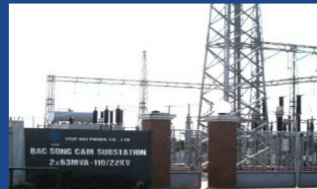
Lắp đặt điện cao thế 2x63 MVA tại công ty BẮC SÔNG CẤM
