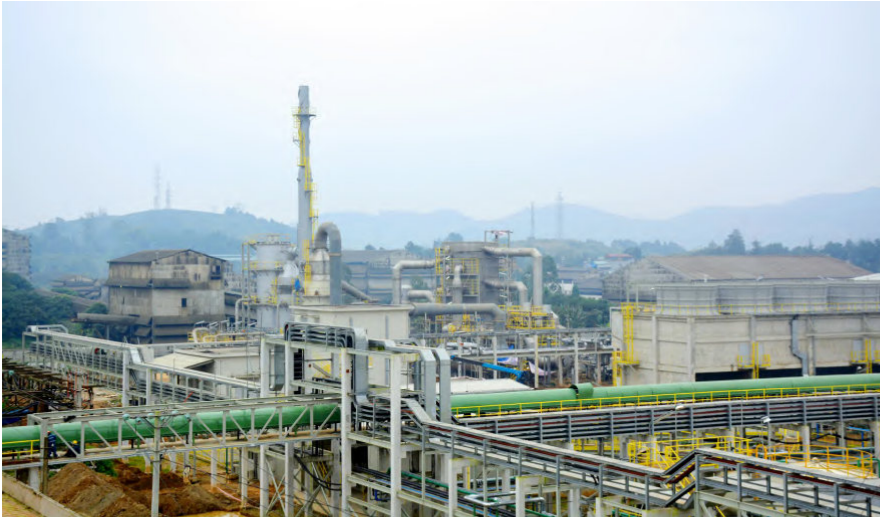
Lắp đặt Nhà máy sản xuất phân bón Diamon photphat (DAP) số 2 Lào Cai
