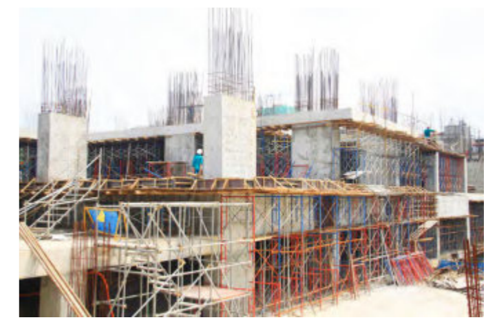
Đổ trụ bê tông và xây hoàn thiện
