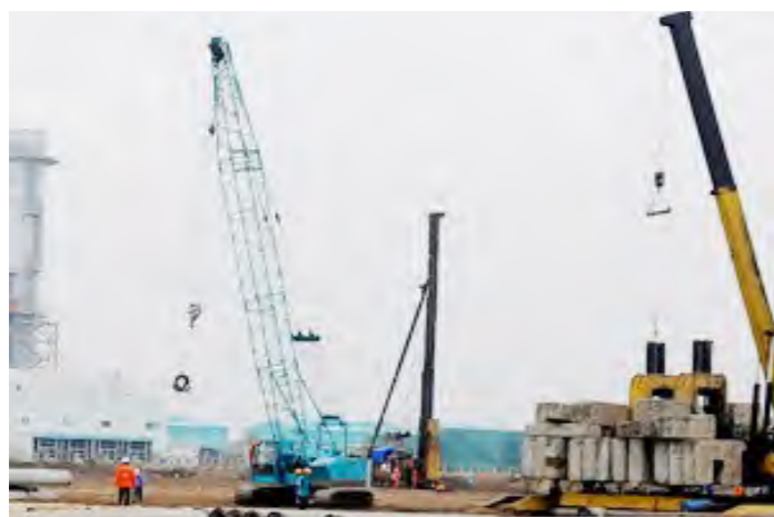
Ép cọc cho nhà máy nhiệt điện Thái Bình 1
