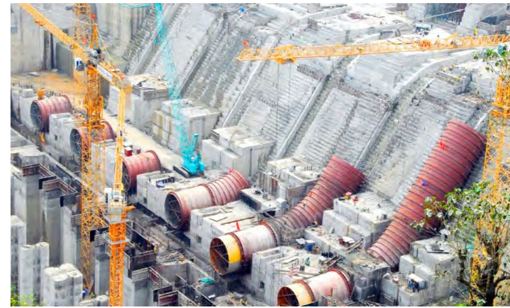
Lắp đặt ống áp lực nhà máy thủy điện Sơn La
