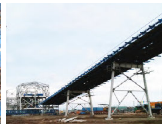
Lắp đặt băng tải than cho các nhà máy nhiệt điện
