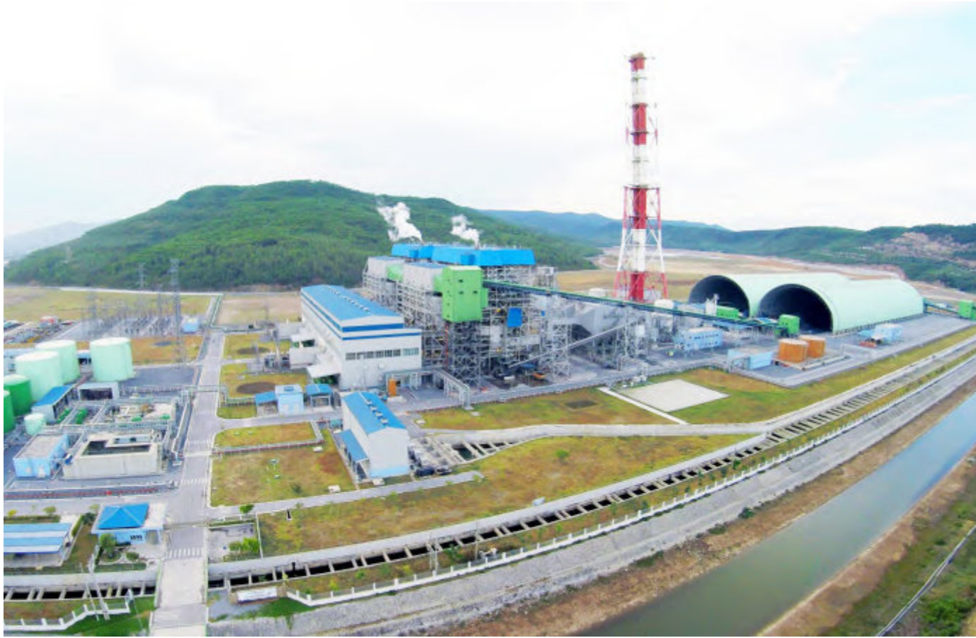
Nhà máy nhiệt điện Nghi Sơn 1 2x300MW
